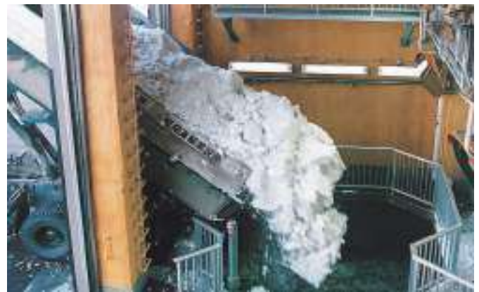
Figura 15 – Depósito para fundir la nieve
