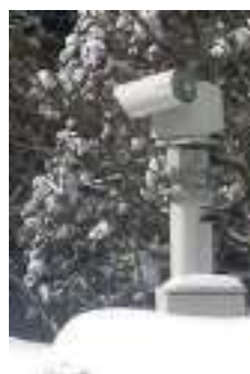
Cámara de vigilancia de la carretera
