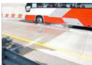
Sistema de riego automático
