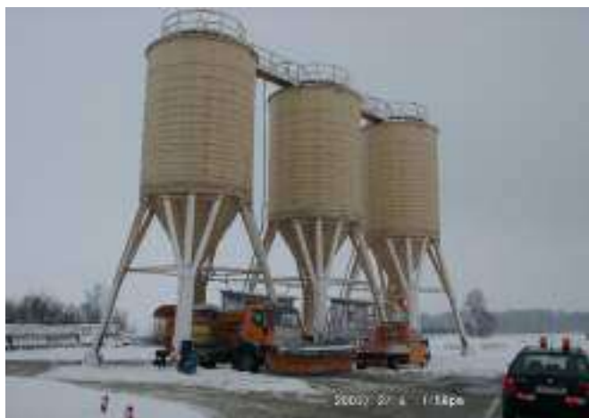
Optimisation du temps de chargement par l'utilisation de silos de stockage verticaux
