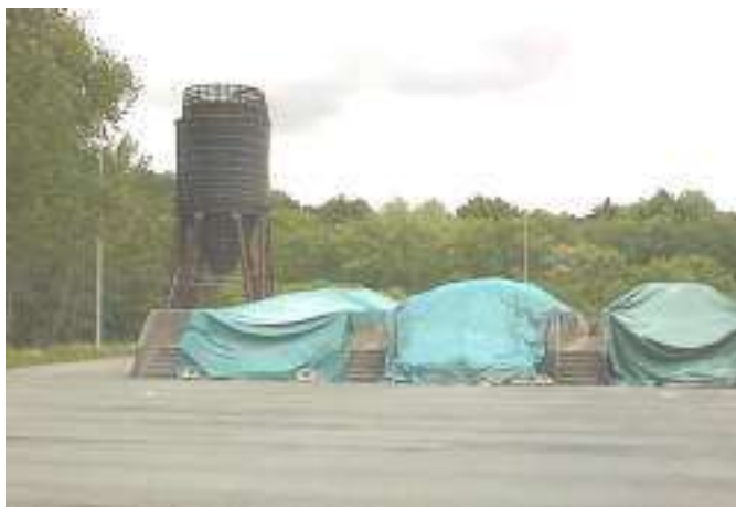
Exemple de silos à sel utilisés en Belgique
