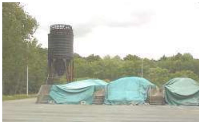
Silos de sal
