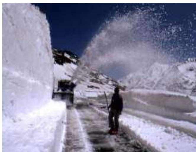
Figure 4 – Enlèvement de la neige dans le Großglockner Hochalpenstraße
