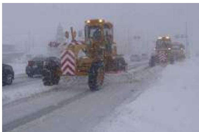
Figura 6 – Retirada de nieve en múltiples carriles
