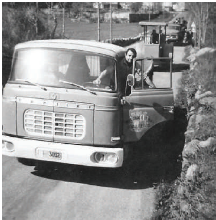
Un dels treballadors del Servei de Carreteres, Antoni Olm, asfaltant la recta de la Margineda el 1974. Foto cedida per Antoni Olm
