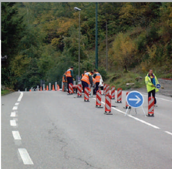
Treballs de col·locació de barrera. Autor: COEX
