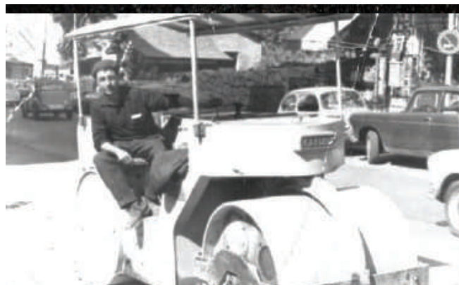
Màquina per a la pavimentació. Autor: Família Miravet
