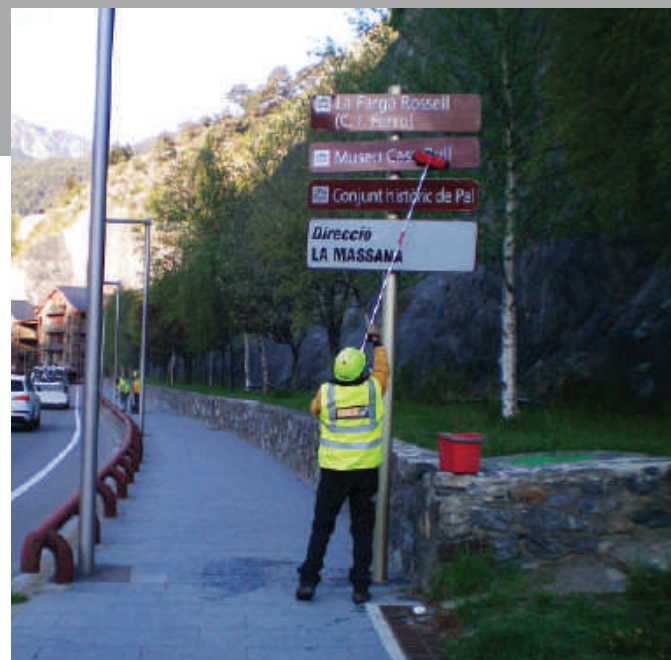
Treballs de manteniment de senyalització. Autor: COEX
