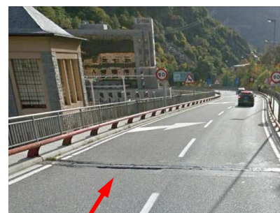
Junta malmesa (elastòmer armat)
